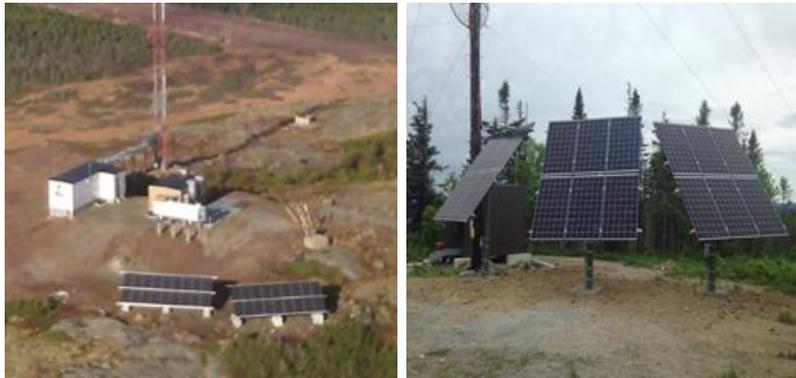
En 2022, Bell Mobilité terminera également la couverture de l'autoroute 6 au Manitoba avec l'ajout de deux nouvelles installations hors réseau. Celles-ci seront équipées du dernier modèle de panneaux solaires photovoltaïques à haut rendement, conçus pour des piles cycliques au lithium, d'un système de refroidissement par ventilateur à courant continu et de générateurs à courant continu, et presque tous les composants de l'abri seront alimentés en courant continu.
