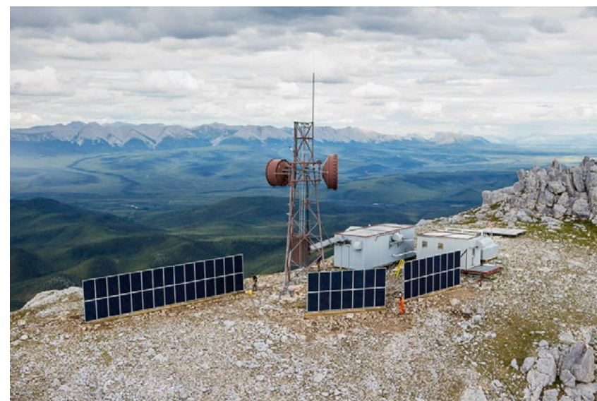
Ensemble de panneaux photovoltaïques au sommet d'une montagne au Yukon, au site d'Engineer Creek de Northwestel le long de la route Dempster.
