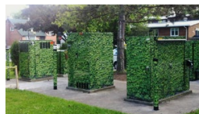
Armoire d'interconnexion camouflée au parc Yitzak Rabin à Côte-St-Luc (Montréal).
