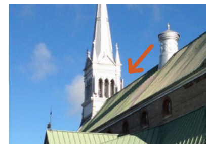
Bell cherche à placer ses antennes sur des structures existantes comme des édifices élevés ou des clochers.
