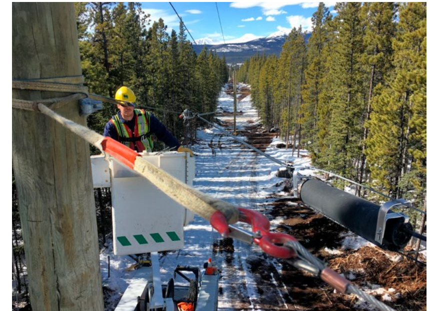
Sur cette photo, le technicien Burt Stephens et son équipe travaillent sur une série de transferts de poteaux près de Carcross, au Yukon.
